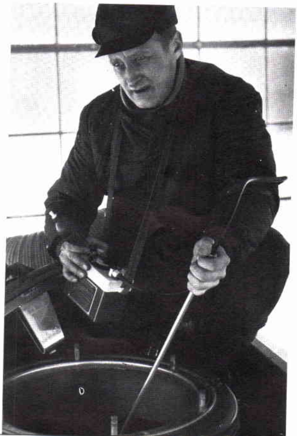
Förman Hellström kontrollerar med indikator att tanken är gasfri.
