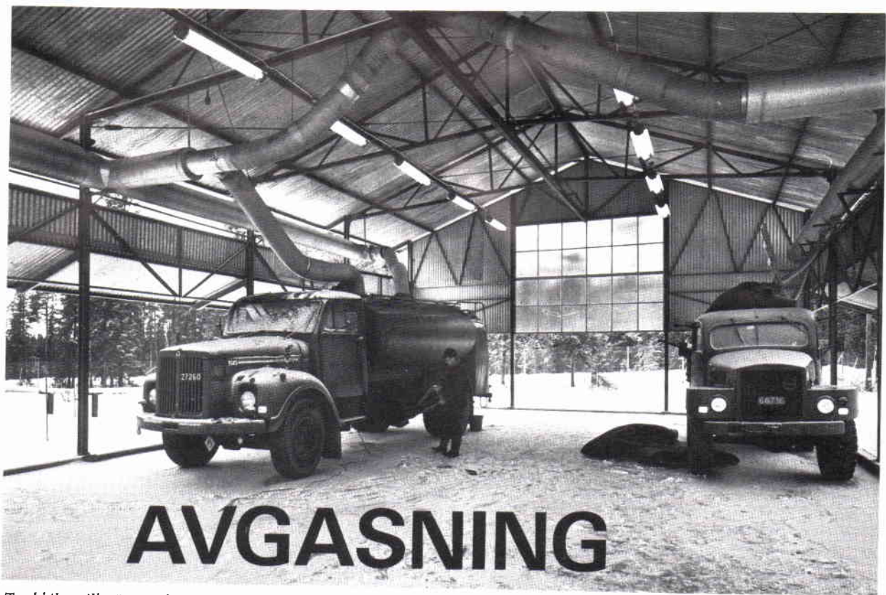
Tankbilen till vänster dräneras genom rörsystemet.
